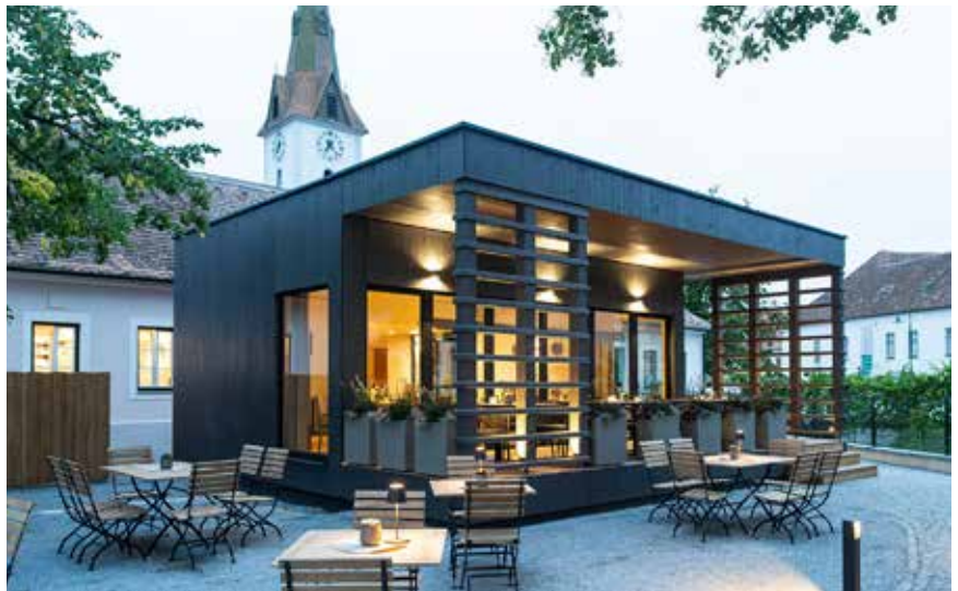
Das „Franz Joseph“ in Obermarkersdorf wurde in einem Teil des ehemaligen Kindergartens errichtet.
