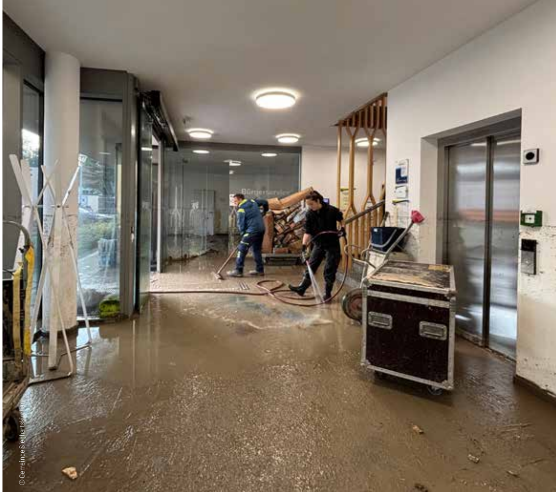
In Sieghartskirchen wurde auch das Gemeindeamt überflutet.
