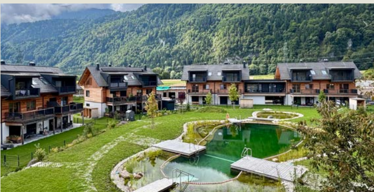
In der Anlage wurde auch ein 500m 2 großer Bio-Schwimmteich errichtet.
